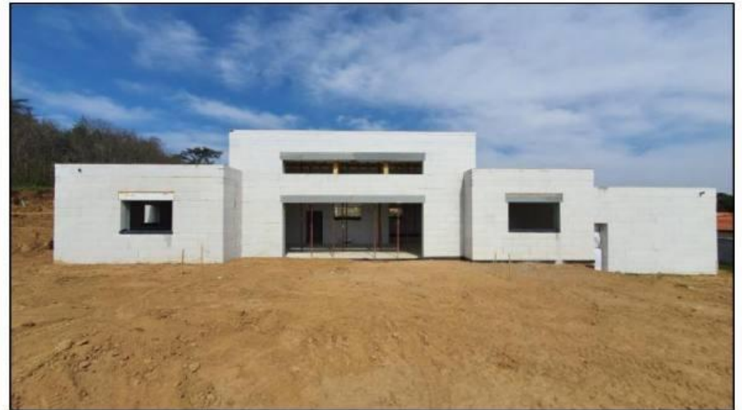
Achèvement de la structure « hors d'eau »
