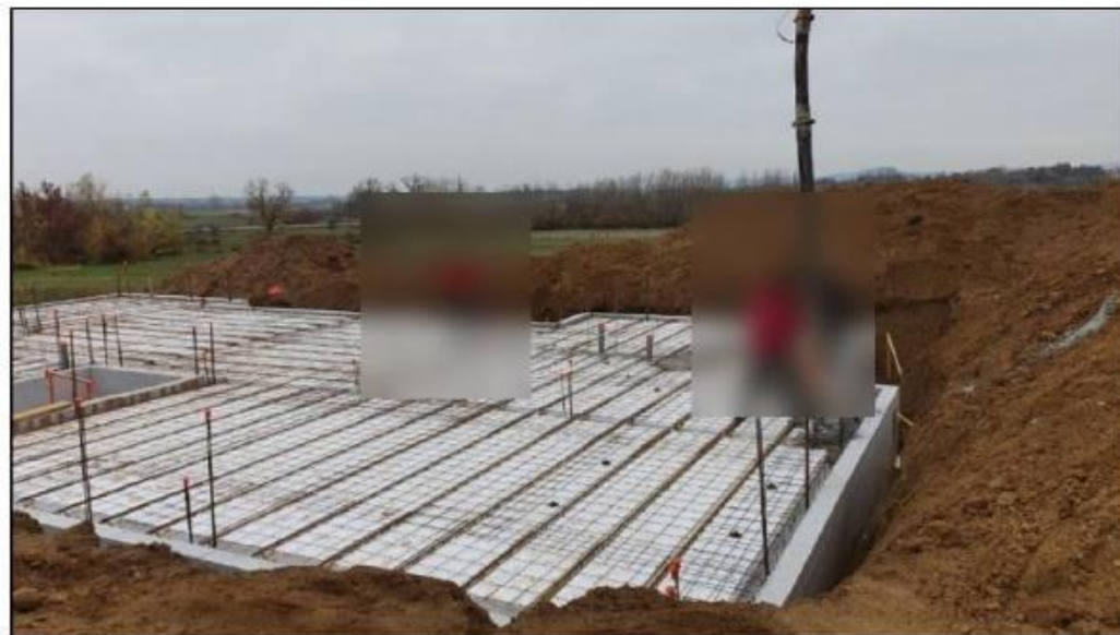
Pose du plancher VS (poutrelles + hourdis)
