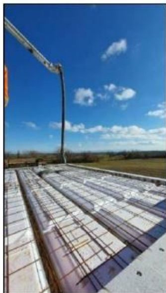
Pose du plancher haut RDC / toiture (poutrelles + hourdis)
