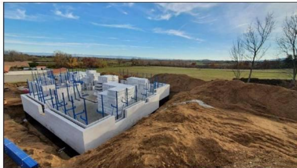
Mise en place des stabilisateurs (etaits) à partir du 3 ème rang
