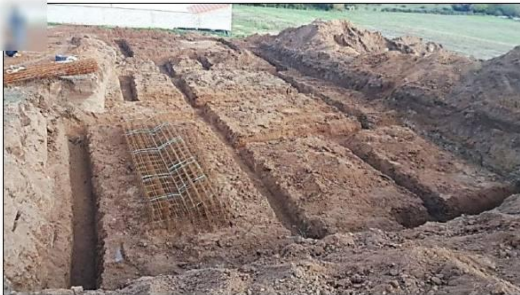
Ouvertures des fouilles
