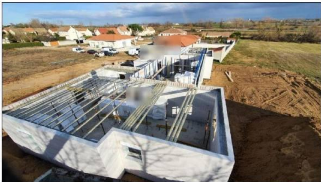
Pose du plancher haut RDC / toiture (poutrelles + hourdis)
