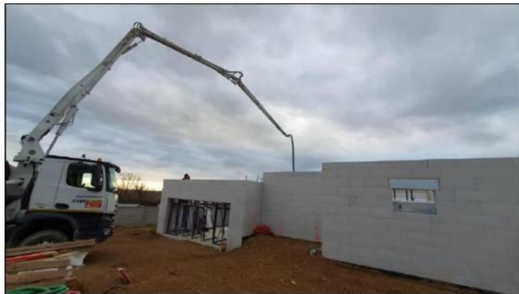
Coulage du béton dans les coffrages REVERBLOC
