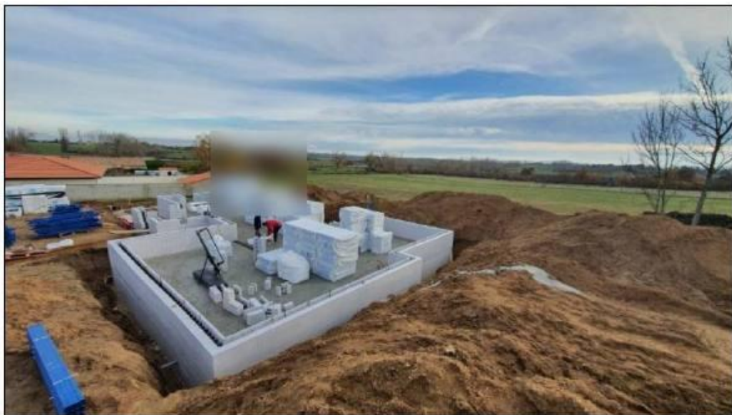
Pose et calage des premiers rangs des blocs de coffrage REVERBLOC
