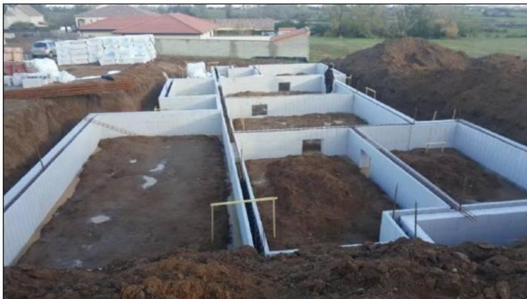
Élévations des murs du VS avec les blocs de coffrage REVERBLOC
