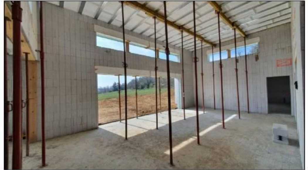
Retrait des lignes d'étais du plancher haut
