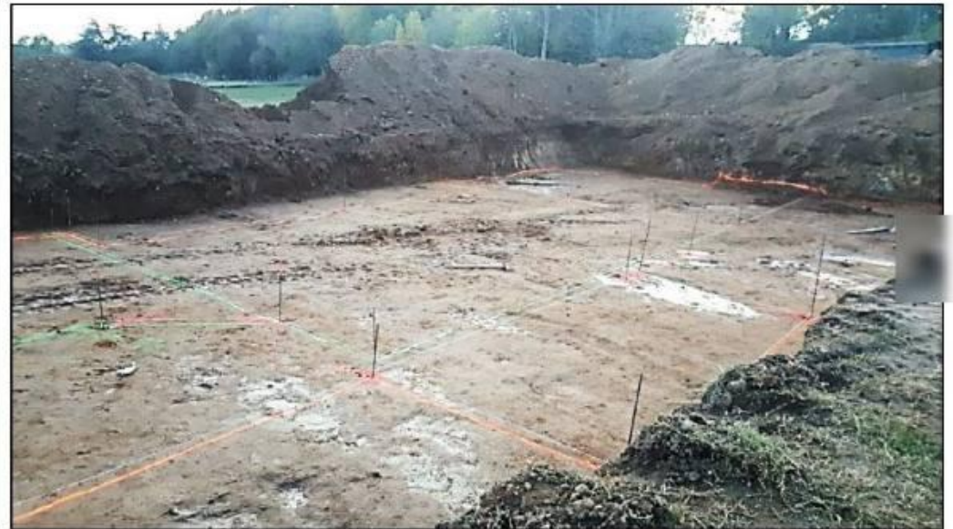
Tracé des fondations
