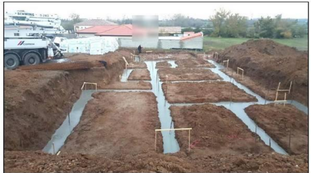
Ferrailage et coulage des semelles filantes
