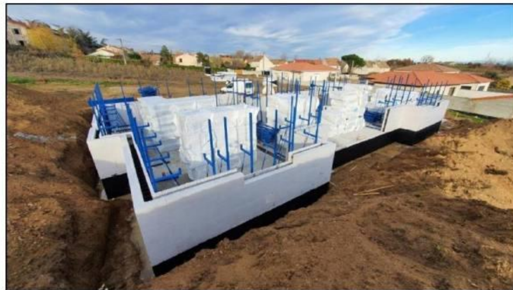
Mise en place des stabilisateurs (etaits) à partir du 3 ème rang
