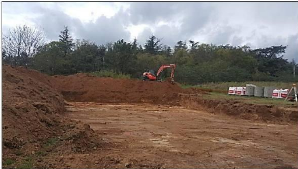
Terrassement de la plateforme d'implantation
