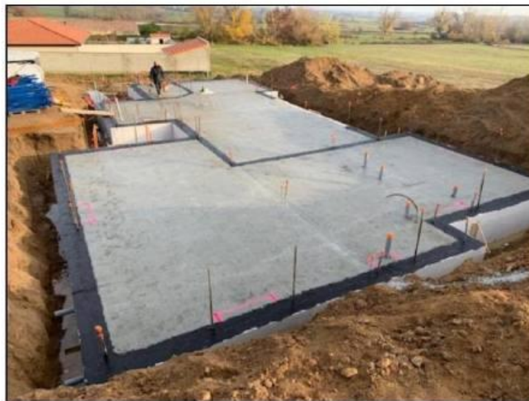
Réalisation d'une arase étanche
