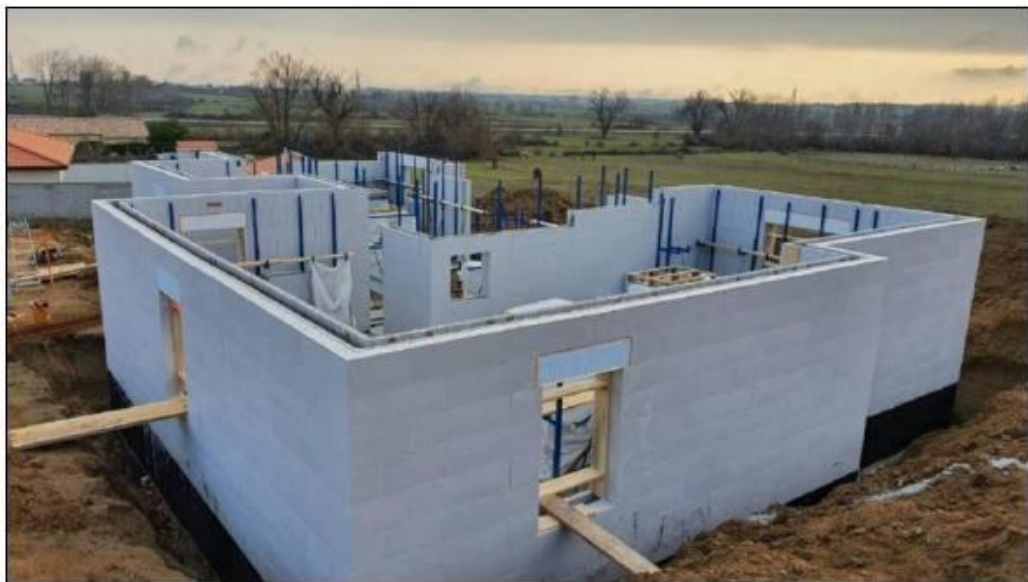
Achèvement du montage des murs
