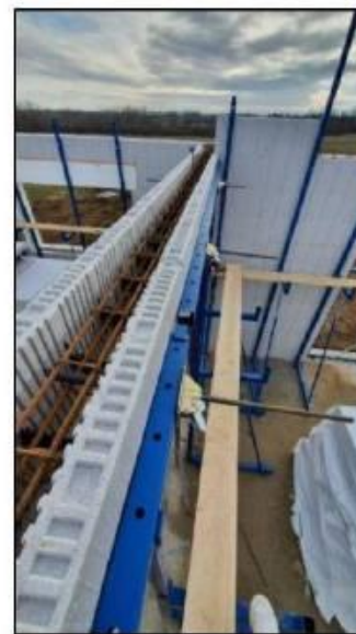
Réalisation de poutre avec les blocs de coffrage REVERBLOC
