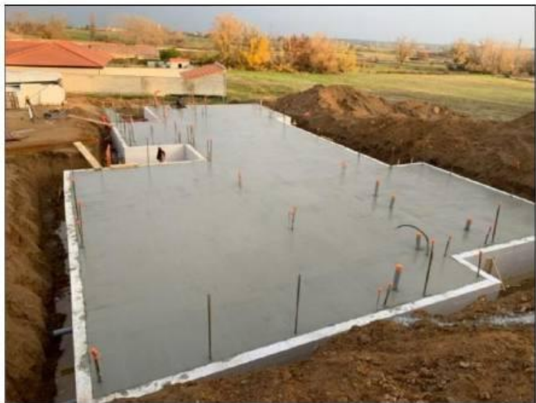
Coulage de la dalle de compression
