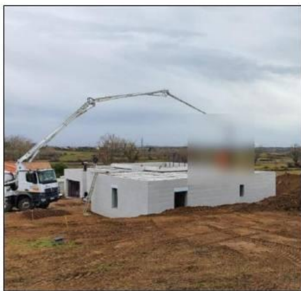
Coulage de la dalle de compression
