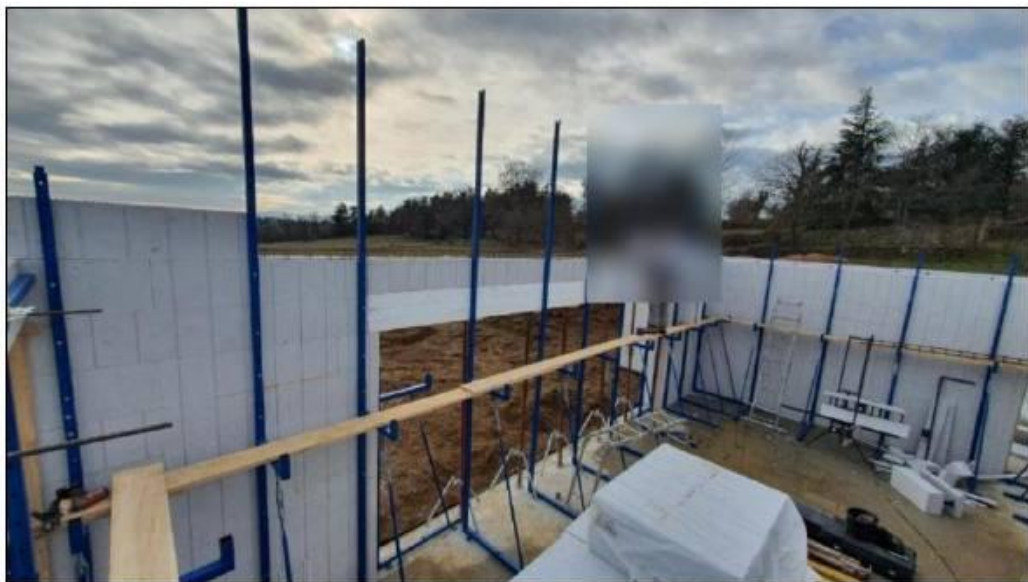
Réalisation des ouvertures et intégration des coffres VR
