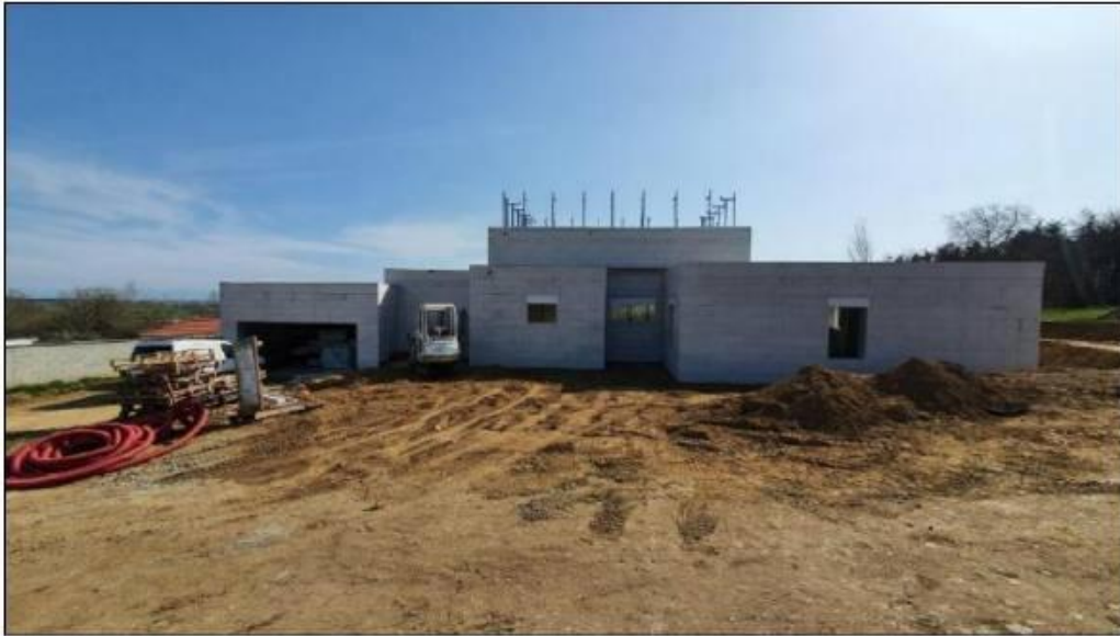
Réalisation des acrotères avec les blocs de coffrage REVERBLOC
