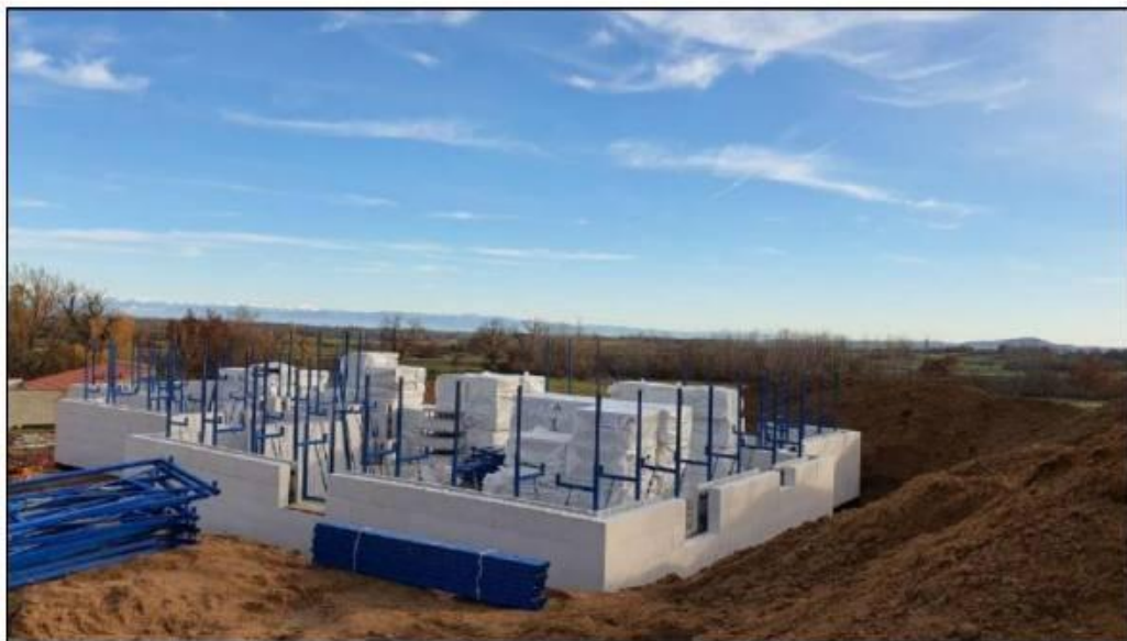
Pose et calage des premiers rangs des blocs de coffrage REVERBLOC
